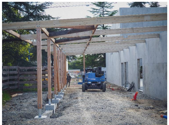
Charpente du studio de danse issue du réemploi © Grand T
