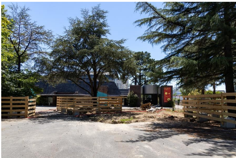
Protection des arbres sur le chantier © Paul Pascal - Département de Loire-Atlantique
